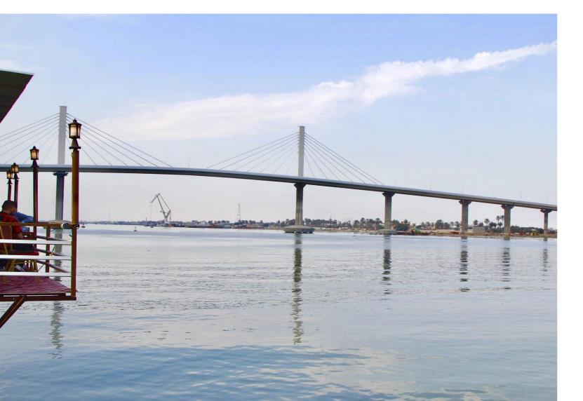
diamètre de 2 mètres plantés dans le sol à une profondeur de 50 mètres, on a utilisé un total de 33 500 mètres cubes de béton. La méthode d'assemblage du pont devait répondre à deux exigences principales : concentrer autant que possible les activités au sol, où les conditions de travail étaient mieux contrôlées et faciles, et éviter les interférences avec le trafic fluvial. La solution a consisté à créer deux zones de pré-assemblage du pont, équipées de grues
