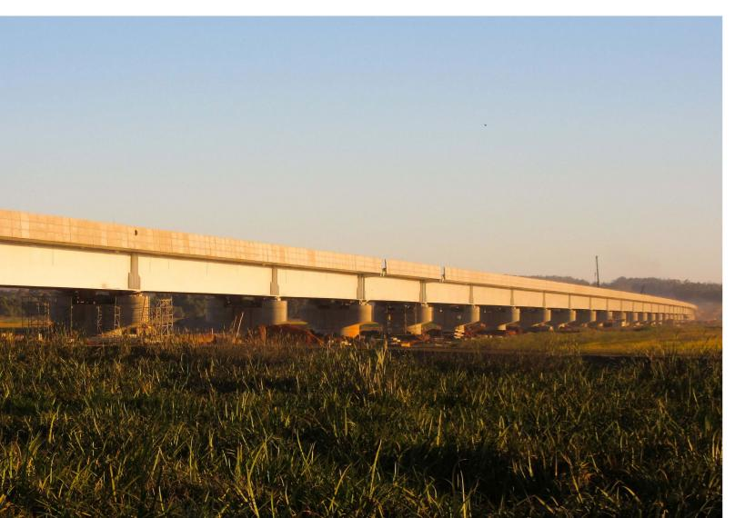
transversales sont constituées de doubles T à différentes hauteurs, localisant les sections majeures au niveau des supports et avec un espacement variable entre 8 et 9,4 mètres. Sur l'âme des poutres transversales il y a une ouverture qui permet aux responsables de procéder à des inspections. Dans la partie inférieure, les prédalles sont positionnées, d'une largeur d'environ 2 mètres, et
