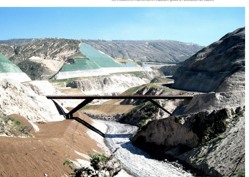
provisoires ; la partie à axe droit du tablier métallique a été lancée tandis que les travées terminales ont été montées à l'aide de grues.
