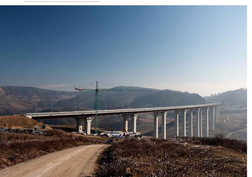
la vallée de l'Aciliu à une hauteur de 80 mètres et repose sur des piliers en béton qui atteignent une profondeur de 40 mètres dans le sol sableux et instable de la vallée. Le viaduc a été assemblé en macro-segments dans un lieu de montage desservi par un pont roulant de 80 tonnes, puis lancé longitudinalement à l'aide d'un avant-bec, en procédant simultanément sur les deux voies par sens de marche.
