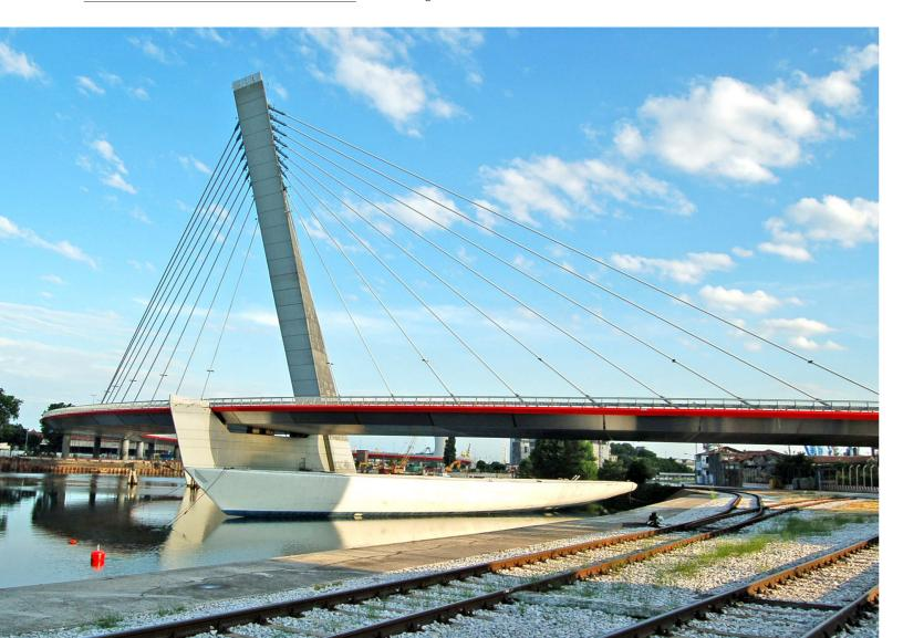
de 19 ° par rapport à l'axe. Dans l'ensemble, le poids de l'acier atteint 4710 tonnes. Pendant la construction, la zone entourant le chantier a toujours été ouverte au trafic portuaire et routier. La particularité de l'assemblage, pour surmonter les limitations considérables à la marge de manœuvre, a consisté à assembler les travées centrales de franchissement de la darse portuaire directement à
